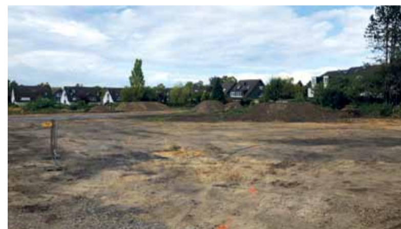
Das Baufeld „An der Burg“ ist bereit für die Neubebauung.
