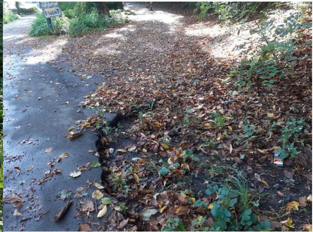
Stark beschädigter Rad- und Gehweg auf der Mettmanner Straße (L239). Teilweise ist der Belag komplett weggebrochen, die Wurzelerhebungen stellen ernsthafte Gefahren dar.
