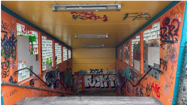
Gleisunterführung Bergstraße / An der Fest Februar 2023
